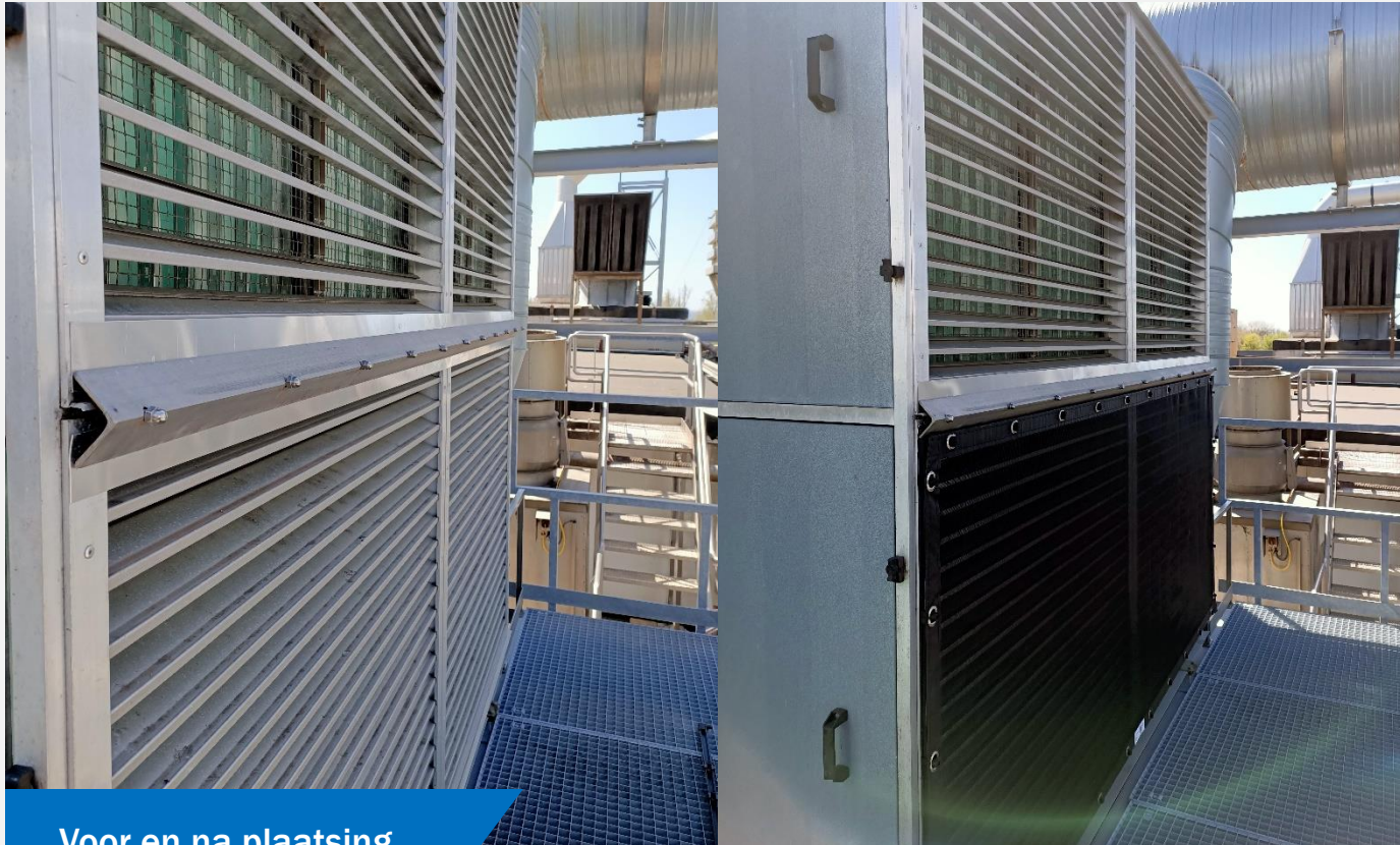
Voor en na plaatsing
